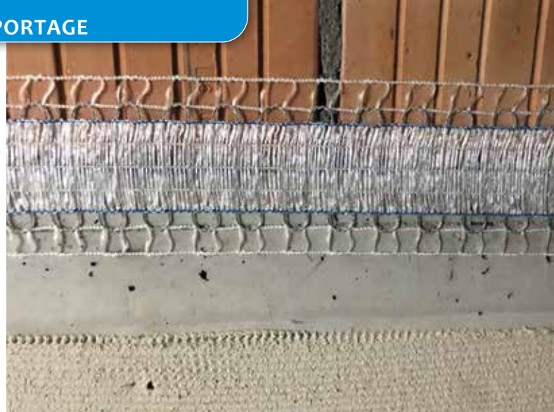
En cas de changement de matériau, on utilise un deuxième produit qui permet à l'enduit de s'accrocher au support des deux côtés de la zone à mailles serrées.
