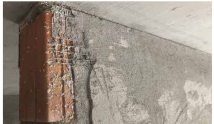
EasyFix en application dans une nouvelle construction à Grabs. On voit bien que l'enduit de base a été appliqué en une seule fois.
